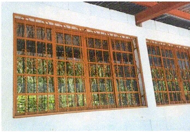
Foto 1: MEJORAMIENTO DE VENTANAS
