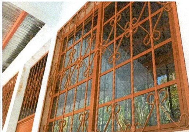
Foto 2: PINTURA EN BALCONES
